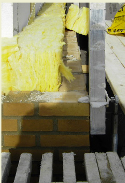
Opstilling til tre korte stræk i een arbejdsgang
