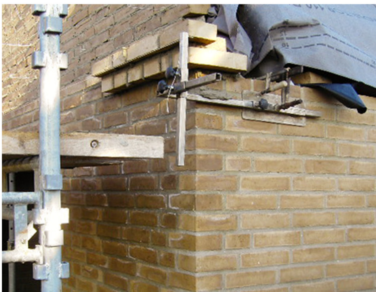
Gesimsholder og vægkonsol monteret
