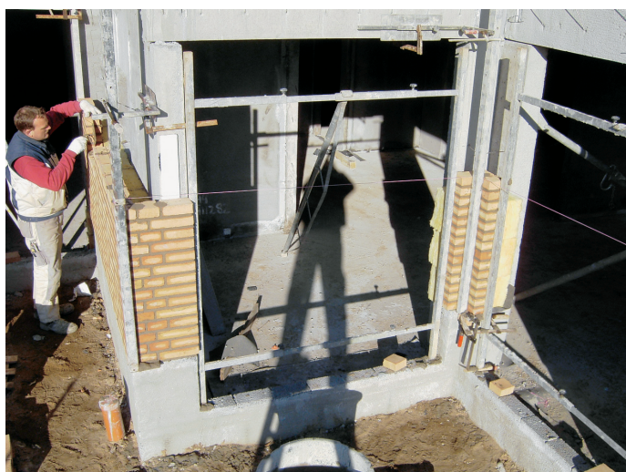
Facade, hvor murerhjørner holdes fast med vægkonsol, dør ramme er monteret i døråbning og vindue
