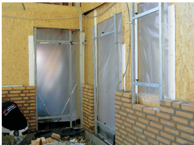
Dør- og vinduesrammer færdigmonteret til opmuring
