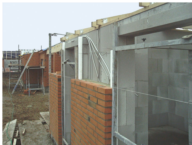
Vindues- og dørrammer er opstillet, så man er fri for at slaglodde. Ved slaglodning kan murværket nemt blive utæt.
