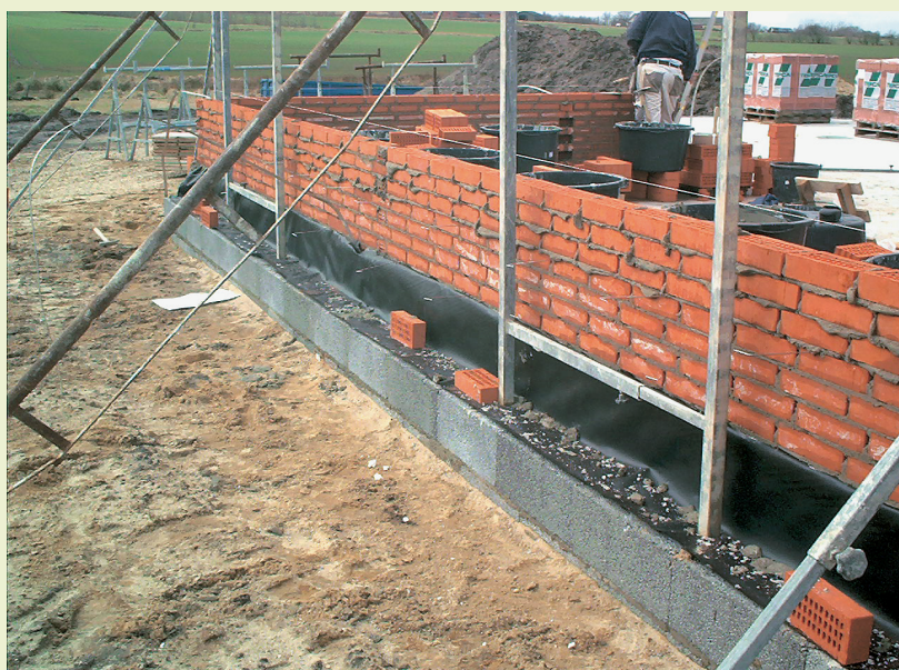
Her opstilles dørrammerne så de passer med bagkant og vinduesfals. Man måler fra udkant af sokkel til første fals, og derefter fra fals til fals
