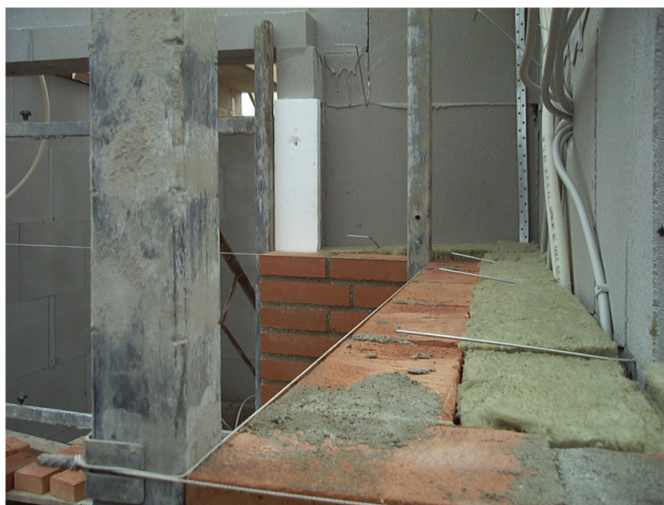
Her vises, hvor let man kan lægge en sten på en udvendig hjørne, uden brug af lodstok.
