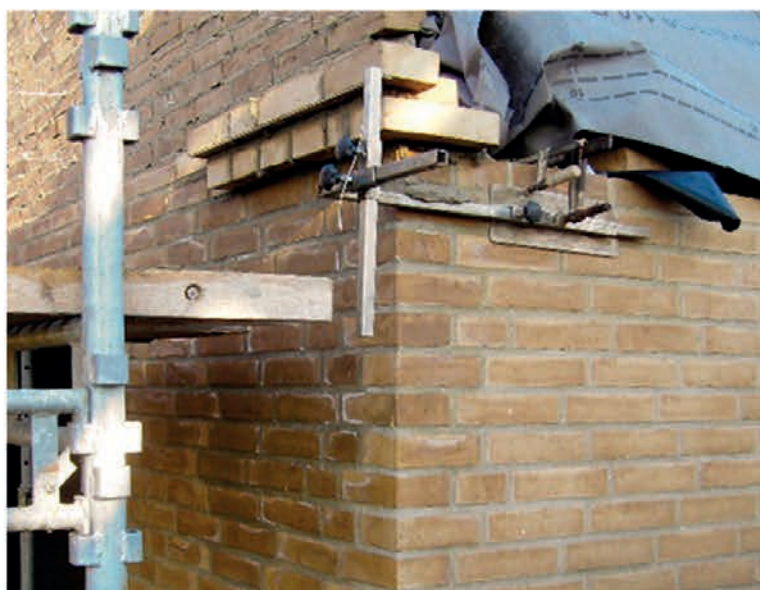
Gesimsholder og vægkonsol monteret
