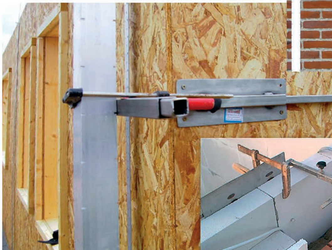
Vægkonsol, der er monteret med skruer, på bagvæg
