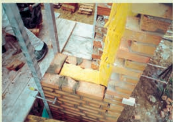
Opstilling til tre korte stræk i een arbejdsgang
