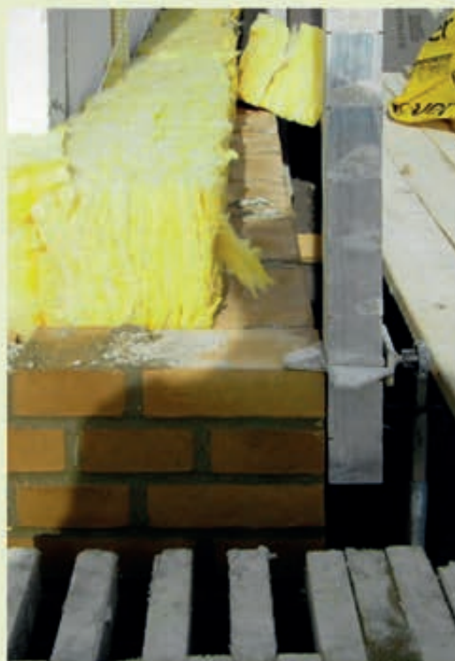
Opstilling til tre korte stræk i een arbejdsgang
