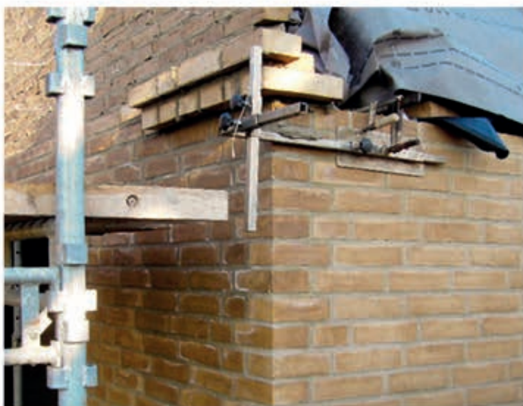
Gesimsholder og vægkonsol monteret
