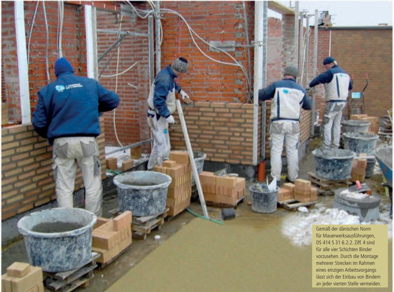
Gemäß der dänischen Norm für Mauerwerksausführungen, DS 414 S 31 6.2.2. Ziff. 4 sind für alle vier Schichten Binder vorzusehen. Durch die Montage mehrerer Strecken im Rahmen eines einzigen Arbeitsvorgangs lässt sich der Einbau von Bindern an jeder vierten Stelle vermeiden.
