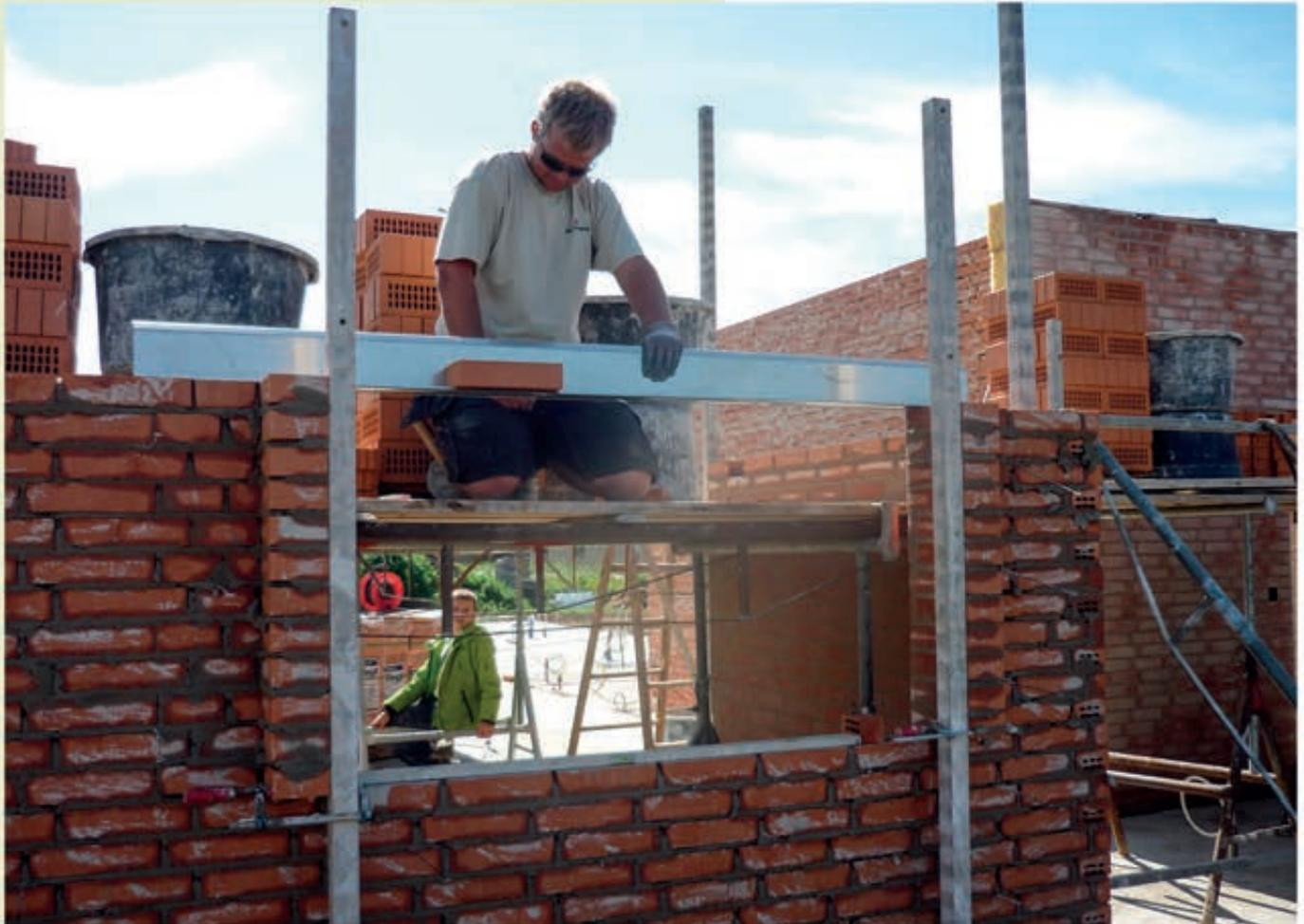
Das Stahlprofil dient zur Erhöhung der Tragfähigkeit, zumal es als Feuchtigkeitssperre in Kombination mit der aufgeklebten Pappe/Mauerfolie funktioniert. Die Tragfähigkeit des Stahlprofils tritt teils im erhärteten Zustand, teils während des Aufmauerns in Erscheinung, wobei es hier als Schablone der aufzumauernden Schichten dient.
