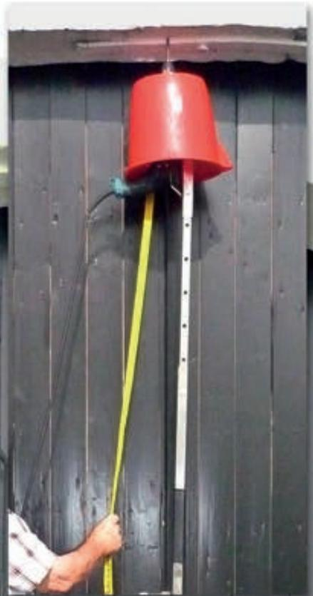
Ein Eimer kann dem Bohrer überstülpt werden, um ihn vor ggfs. absickerndem Wasser aus der Betondecke zu schützen. Der Einsatz einer Leiter erübrigt sich, zumal der Bohrer vom Fußboden aus gesteuert werden kann.
