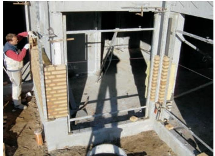
Fassade, bei der Mauerecken mittels einer Wandkonsole festgehalten werden, wobei der Türrahmen in Türöffnung und Fenster montiert wurde.
