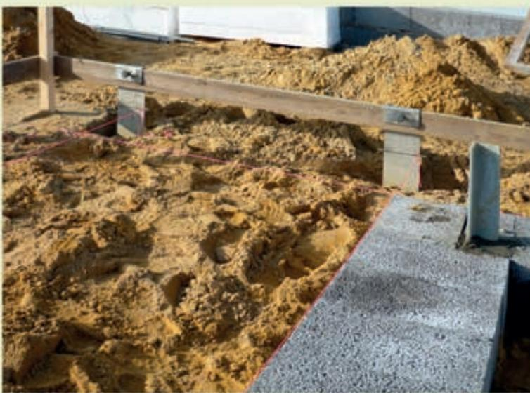
Hier ist die Schnur abgesenkt worden, so dass man den ersten Block ohne Wasserwaage und Zollstock verlegen kann, zumal sich der Schnurbockschnurhalter einfach montieren lässt.
