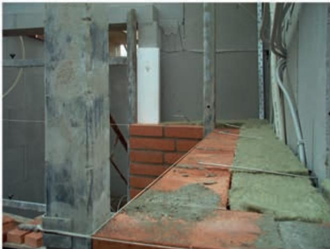
Der Abbildung ist zu entnehmen, wie leicht sich das Verlegen eines Steins bei einer Außenecke ohne Einsatz einer Wasserwaage gestaltet.
