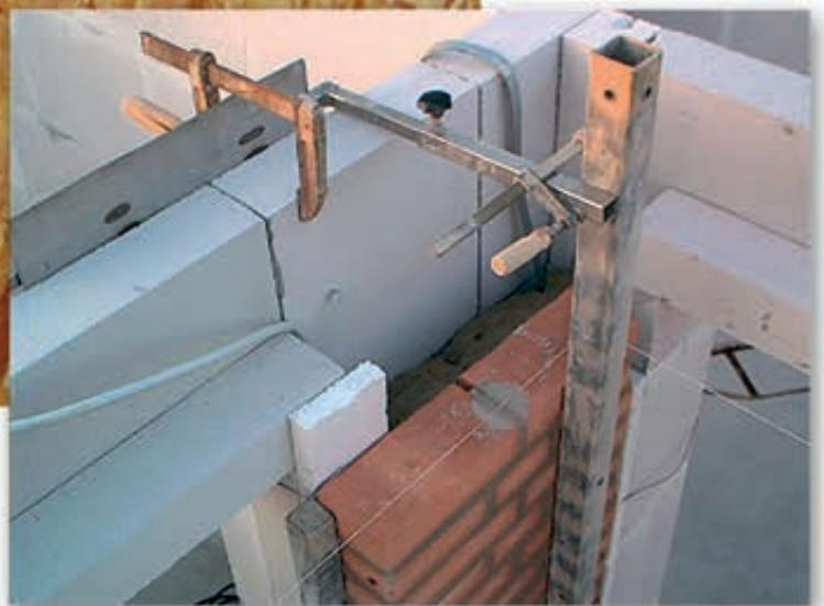
Mit Schrauben befestigte Wandkonsole auf Rückwand.
