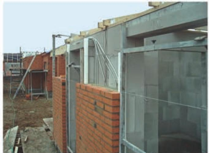
Fenster- und Türrahmen sind so aufgebaut worden, dass sich das Hartlöten erübrigt. Aus dem Hartlöten ergeben sich leicht undichte Stellen im Mauerwerk.
