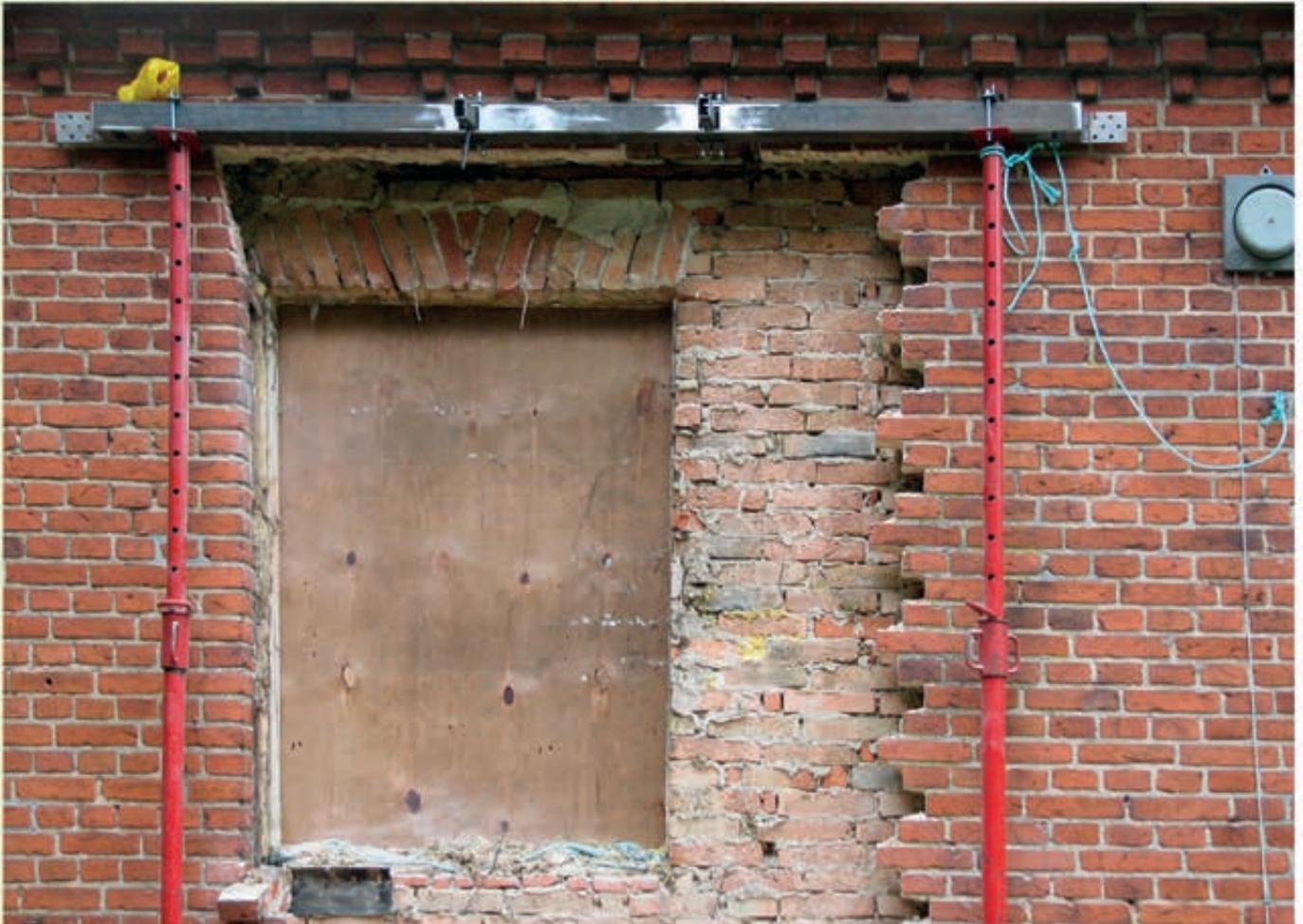
Zur Veranschaulichung der Funktion des Tragbalkens wurde hier ein 1908 erbautes Haus aus reinem Kalkmörtel mit nur zwei zugänglichen Schichten zwischen Stich und Zahnschnittfries gewählt. Hier soll ein bestehendes Fenster durch eine Tür zum Garten ersetzt werden, wobei die Öffnung um ca. 0,5 m zu verbreitern ist. Der bestehende Stich soll somit entfernt und durch einen neuen ersetzt werden. Während dieses Vorgangs trägt das eigens hierfür entwickelte Werkzeug den Aufbau.
