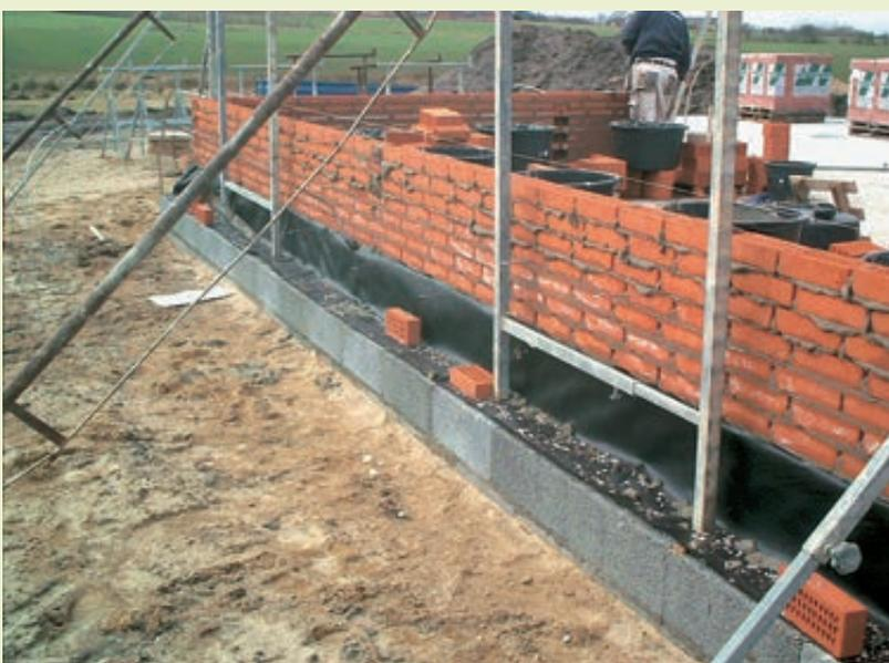
Hier werden die Türrahmen so aufgestellt, dass sie zu Hinterkante und Fensterfalz passen.
