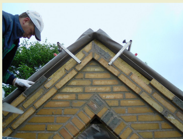
Opmuring af gesims, vægkonsollen holder snoren på plads
